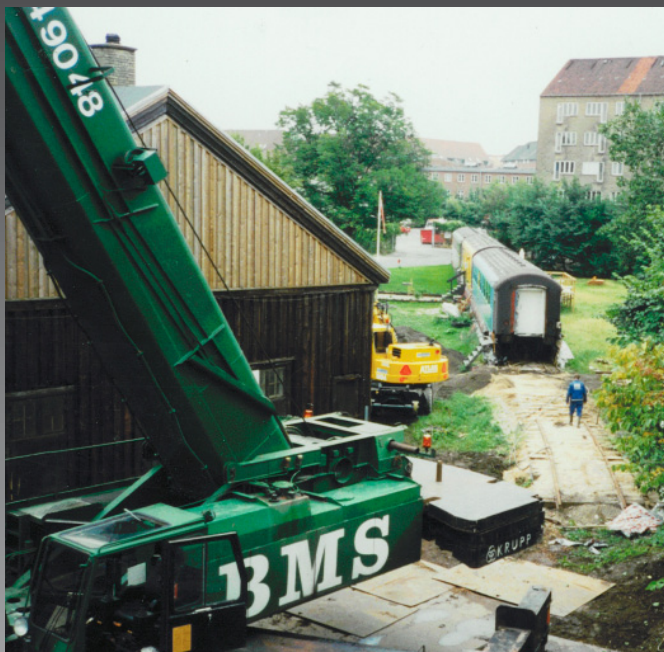
Skiftesporet sættes på nyanlagte jernbaneskinner 1993
